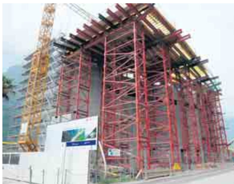
Proseguono i lavori per realizzare la torre di controllo ferroviaria. (Demaldi)
